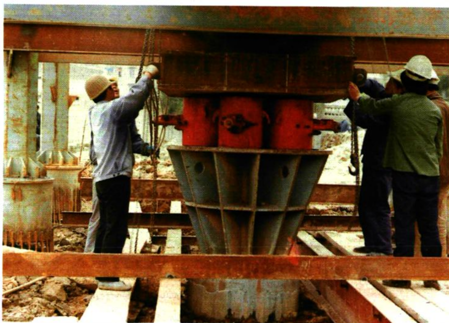
厦门特区福联工贸大厦桩基1500吨试压
