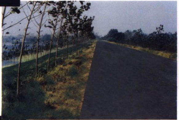
●加固后的南阳湖北大堤
