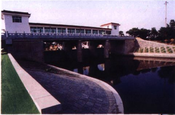
●老运河河口挡洪闸 2001年8月建成
