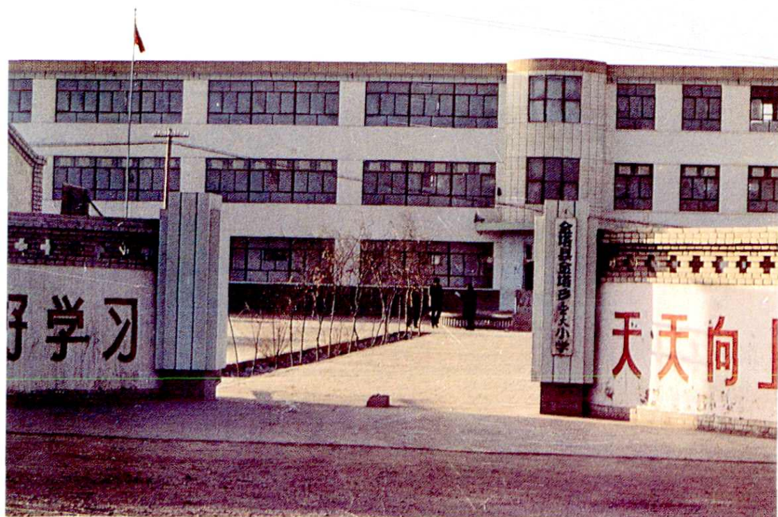
金塔乡金大村小学教学楼
