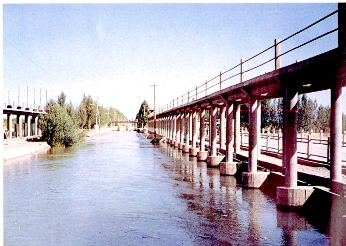
西干渠平交道
