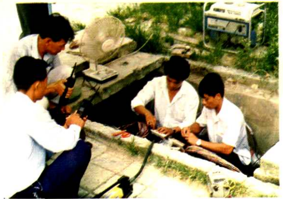
电缆修理员正在检修进局通信电缆。
