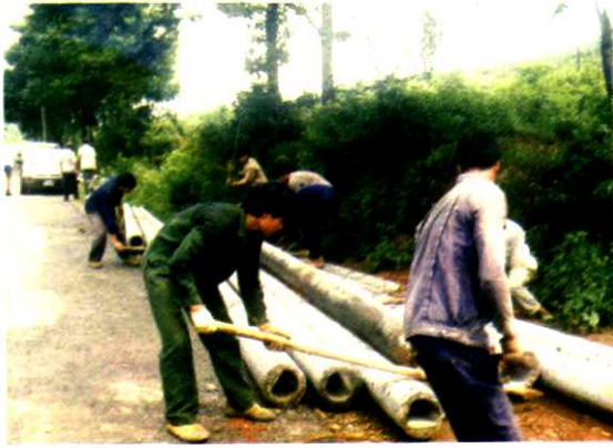
桂林至梧州光缆工程施工时装运的水泥杆。
