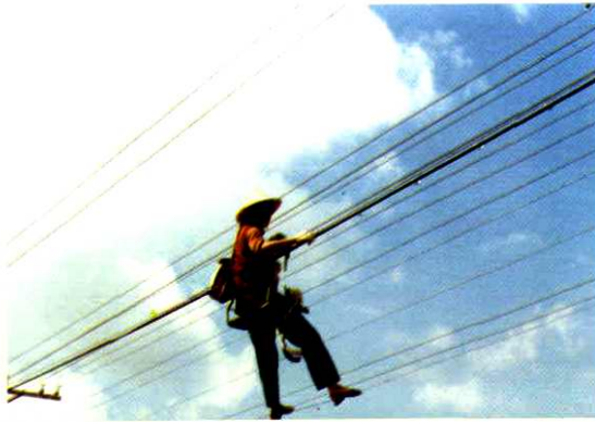
线务员坐吊椅在装设光缆挂钩。
