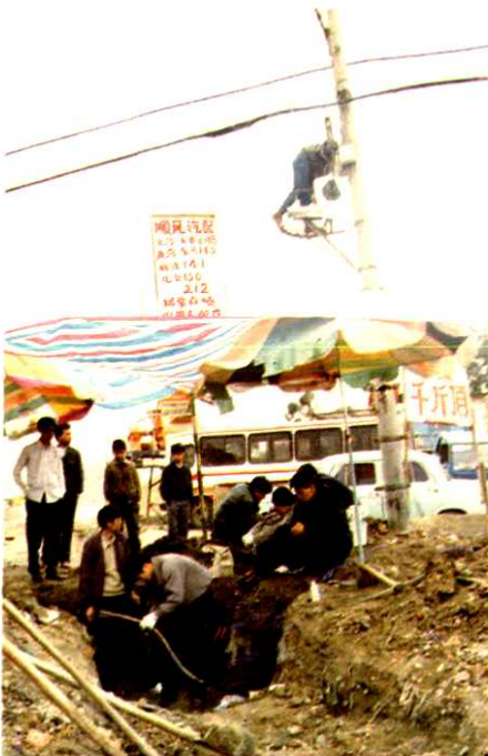
抢修光缆现场。
