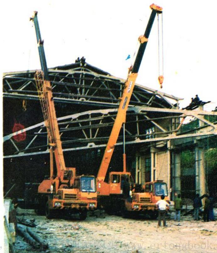
二十五吨吊车起吊厂房构件。
