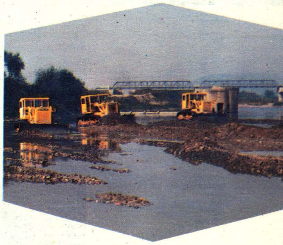
水源维修队正抓紧进行水源维护
