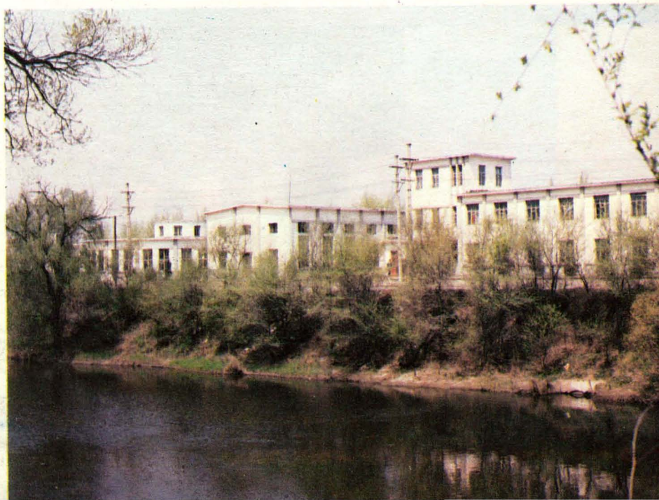
永安工业净水厂
