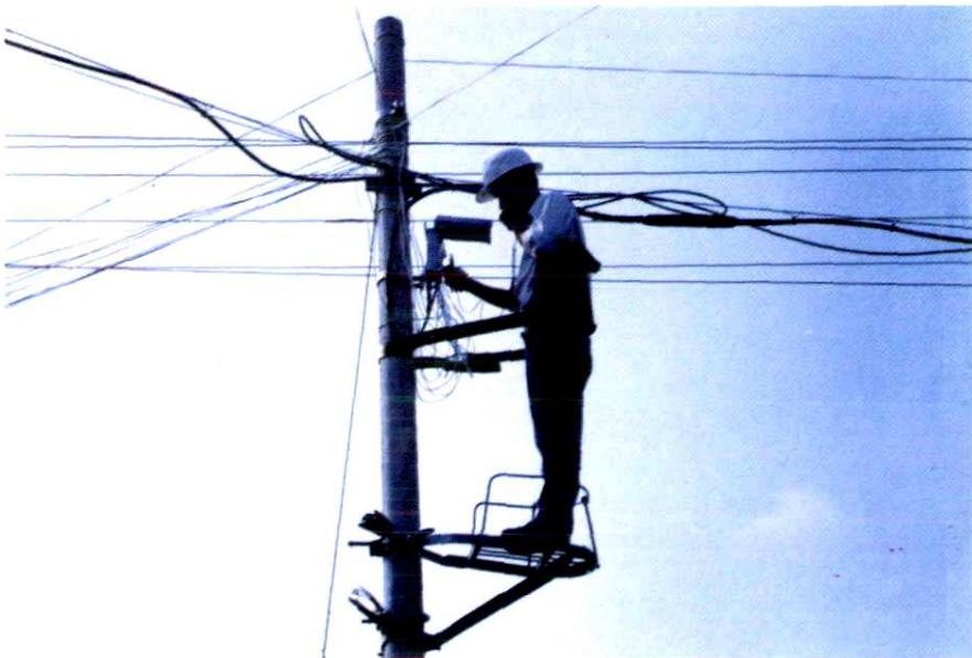
市话线路维修
