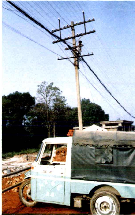
农话线路维修
