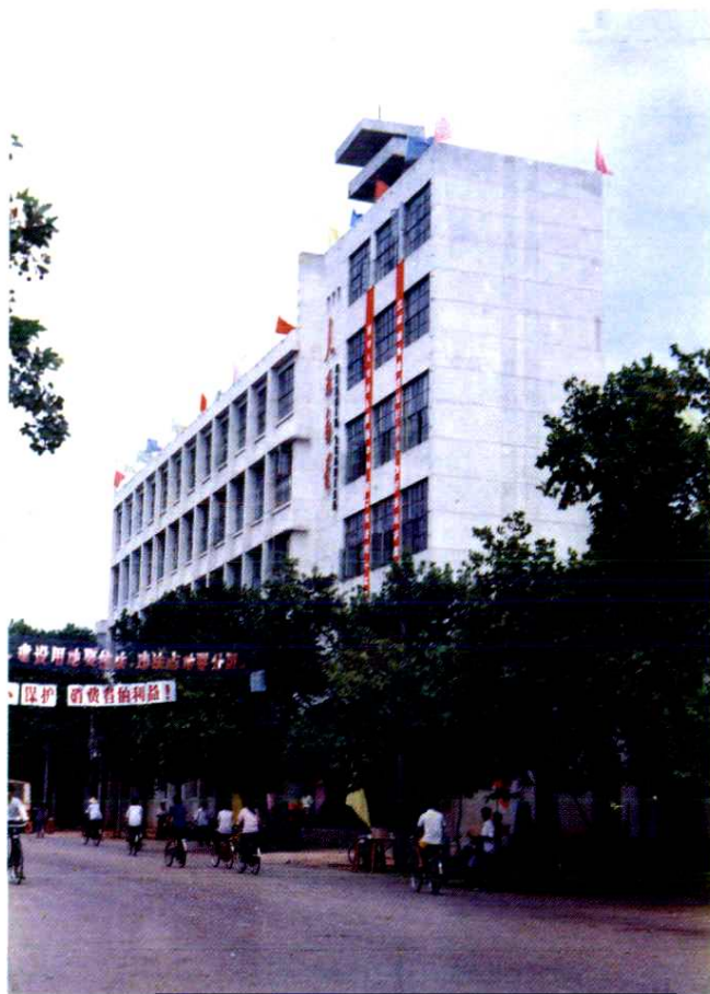
赣县邮电局综合生产大楼
