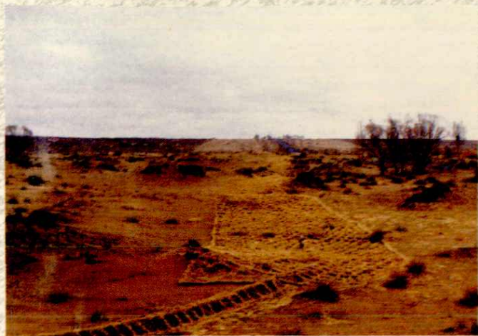
采用固沙技术维护光缆线路
