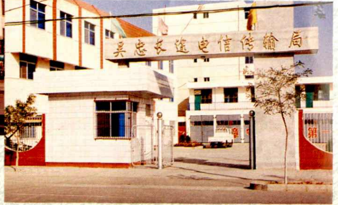
吴忠传输局新建的办公楼
