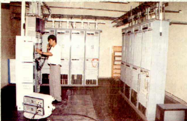
工程技术人员精心检修通信设备
