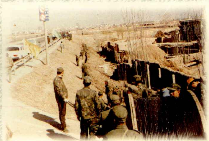
1996年4月，济石太银光缆干线施工现场
