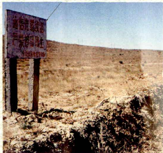
京呼银兰光缆干线青铜峡段直埋式线路
