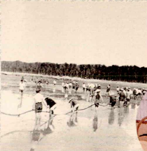
1975年，京呼银兰 干线石嘴山黄河渡口敷 设水底电缆
