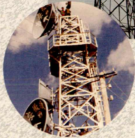
数字微波工程中，施工人员安装天线
