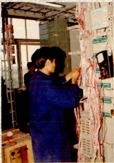
数字微波工程中，工程技术人员精心施工
