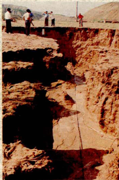
抢修 遭洪水冲 击的光缆 线路
