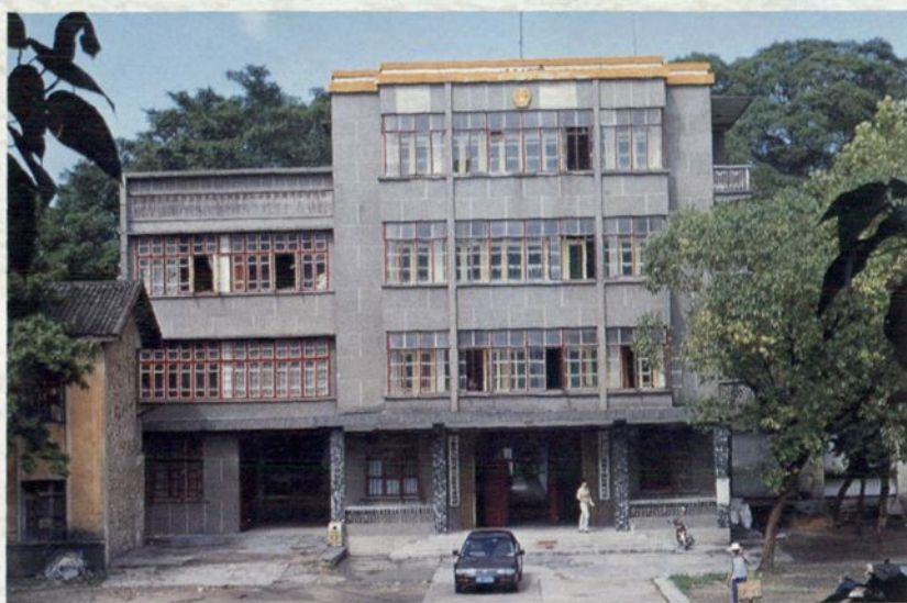
于都县人大常委会机关办公大楼
