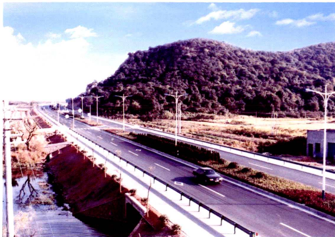
公司承建的09省道余杭段改建工程(1997年)
