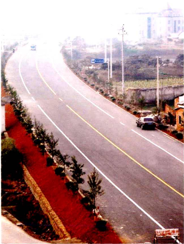
公司承建的县道干线塘(栖)康(桥)公路(2003年)
