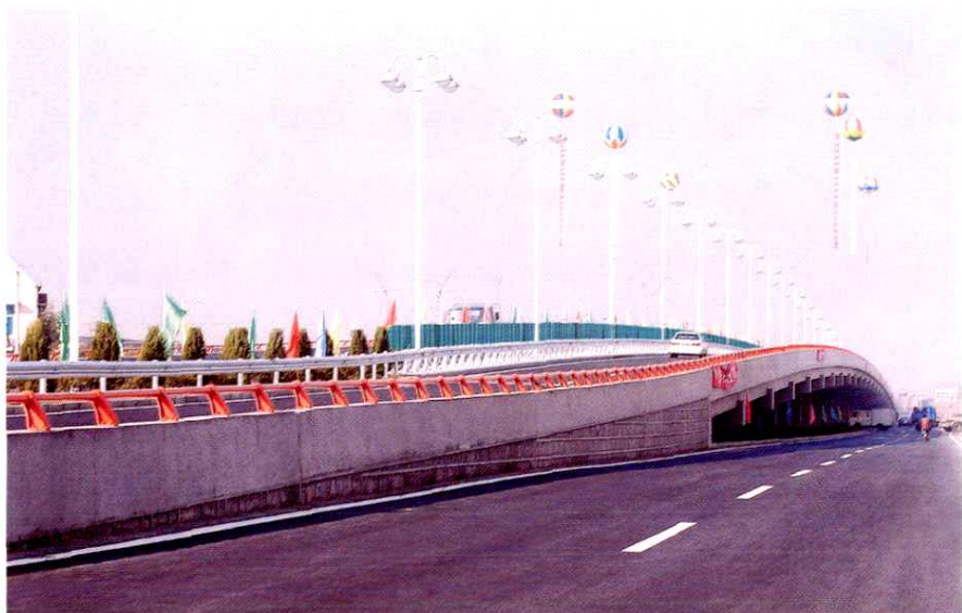
公司承建的104国道瓶窑华兴立交桥(2004年)
