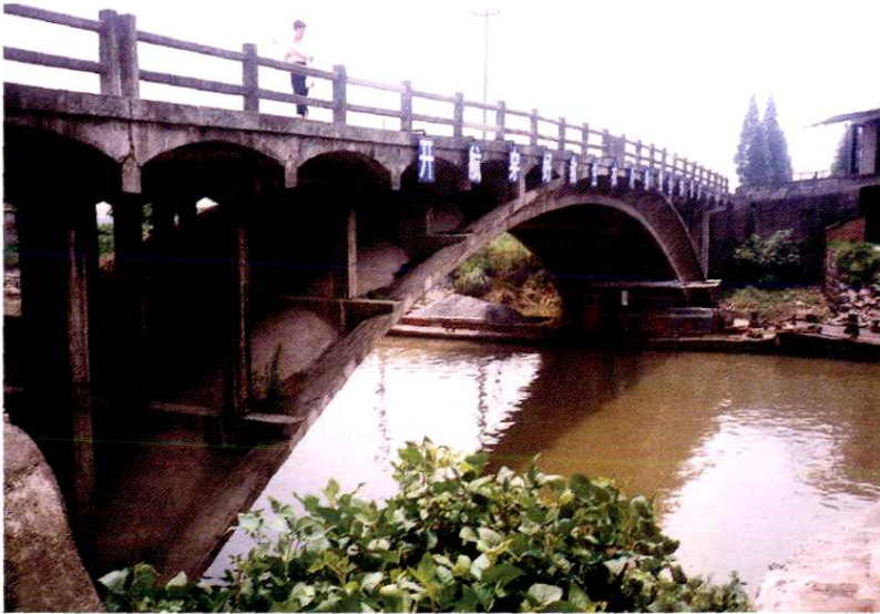
桥梁工程队承建的箬山 大桥(1980年)
