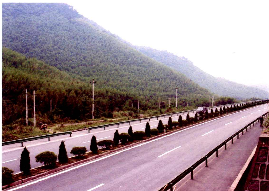
公司承建的04省道余杭段改建工程(1999年)
