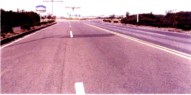
公司承建的海宁观潮大道(1999年)
