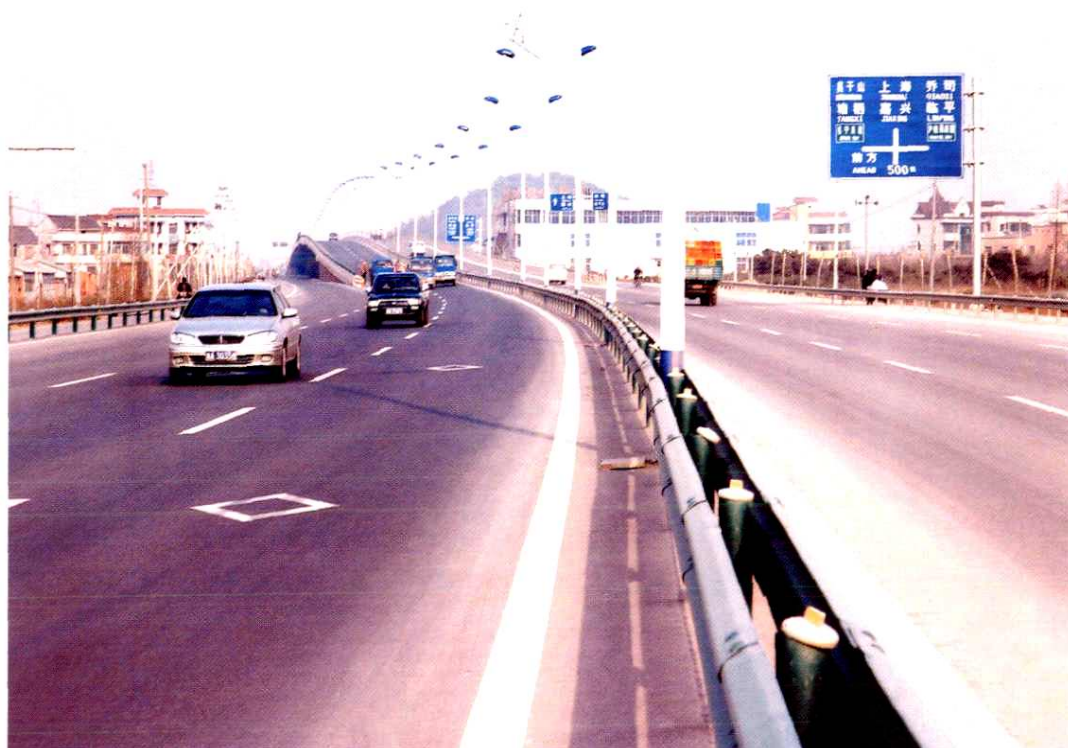
公司承建的320国道余杭段二标段工程(2003年)
