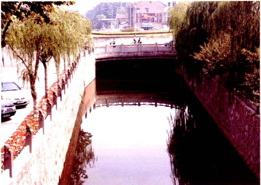
公司承建的临平恒达桥交叉工程(1997年)
