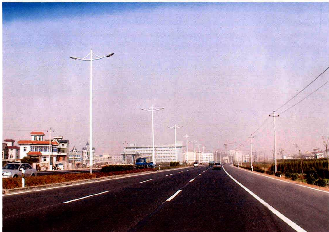
公司承建的01省道余杭段改建工程(2004年)
