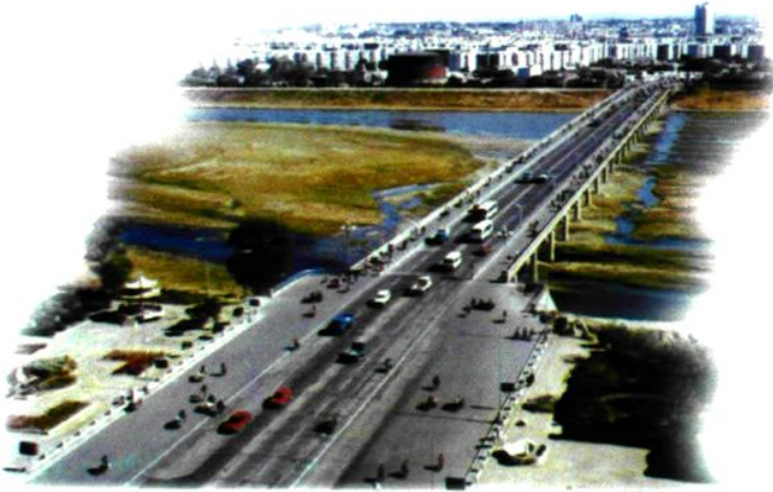
锦州小凌河西大桥全貌
