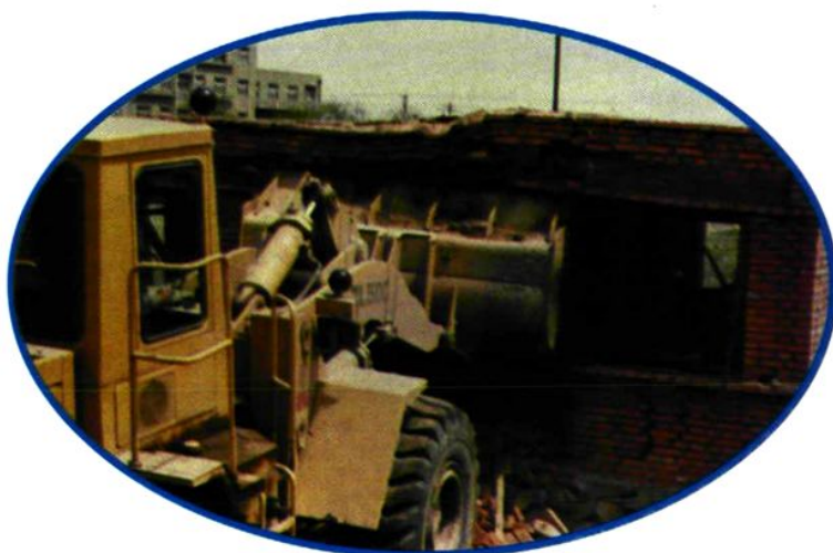
强行拆除 违法占地建筑
