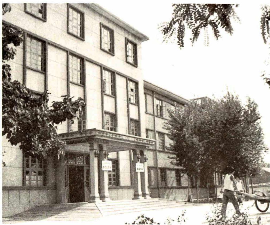
县供销社办公大楼
