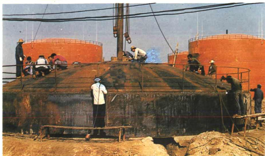
金属大罐组装
