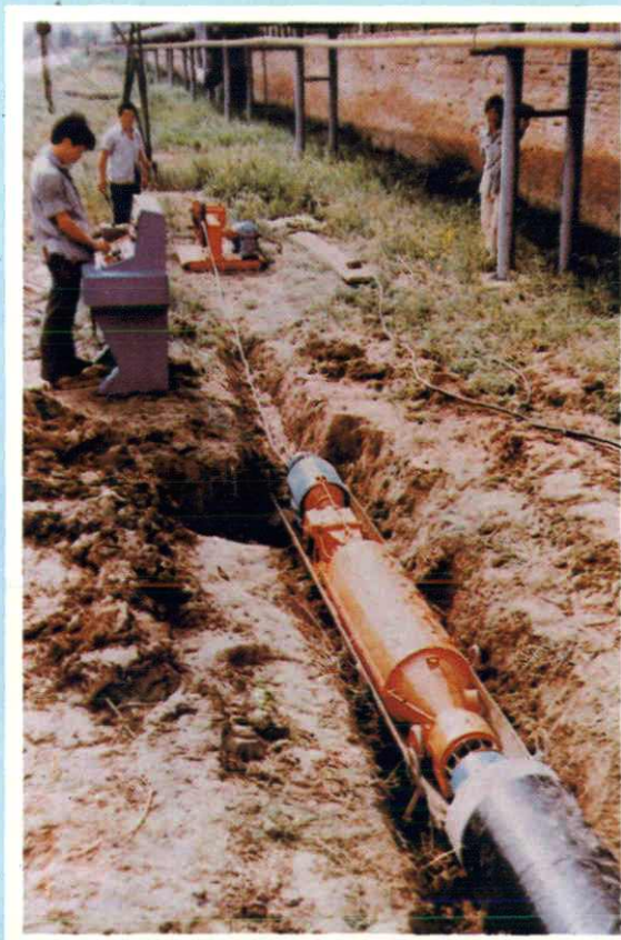
1987年自行设计制造成功 SC— \varnothing 426 砂浆内衬涂敷机， 1988年获国际防腐技术鼓励奖。
