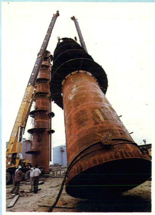
整体吊装原油稳定塔。
