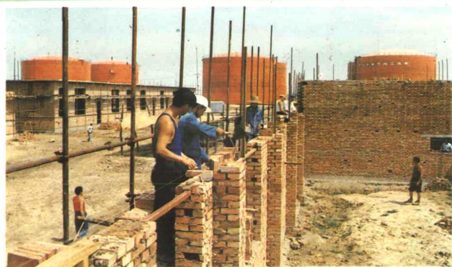
土建工程施工
