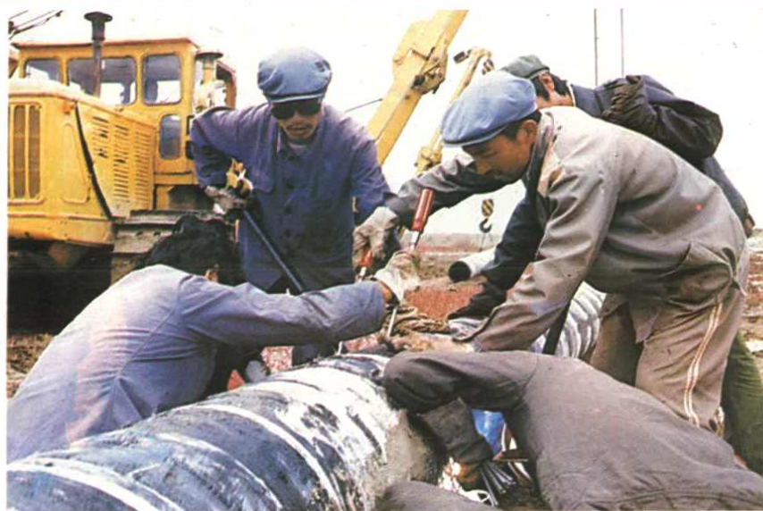
抢建管道工程
