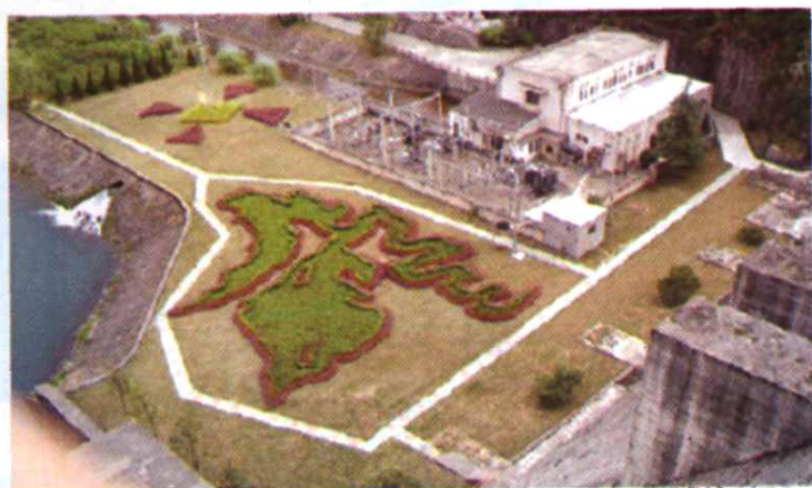
水库坝后电站
