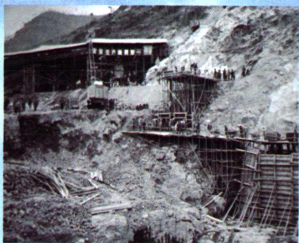
大坝坝基浇筑现场
