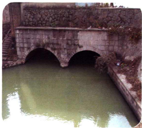
亭下水库渠道萧镇进口
