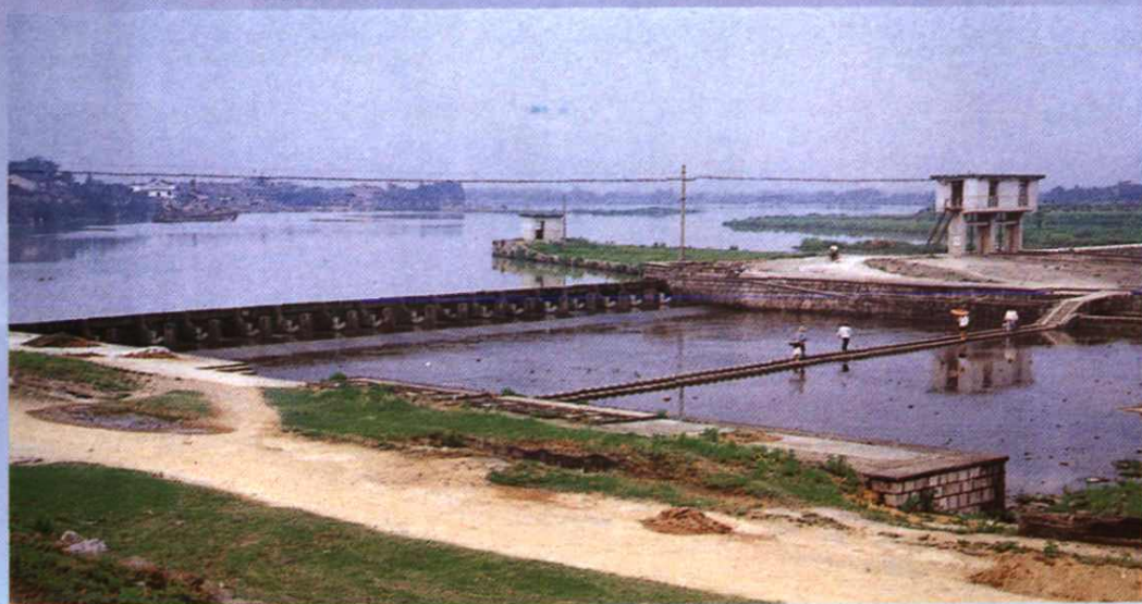
萧镇活动堰枢纽工程
