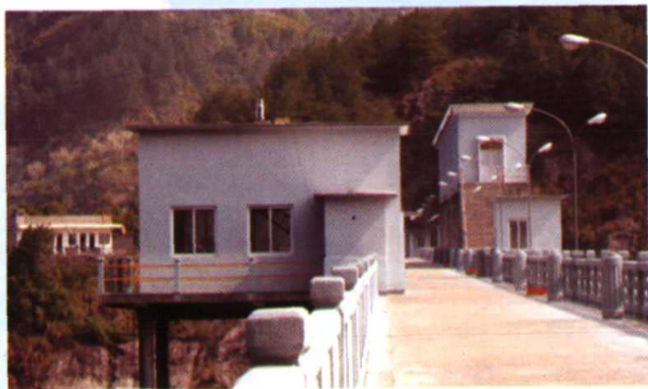
大坝闸门启闭机房
