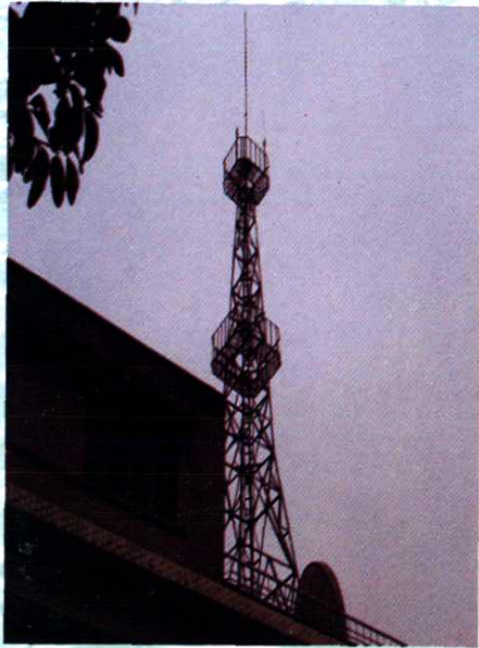
遥测接收铁塔
