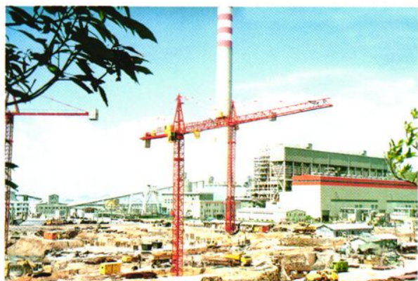
建设中的沙角C电厂工地
