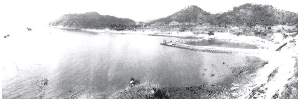
建设前码头原景（1983年）
