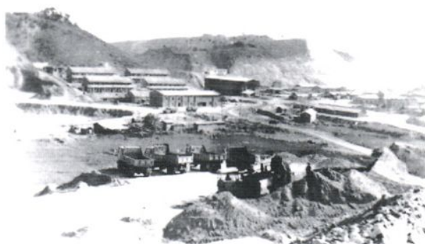
图为施工现场(1985年1月)
