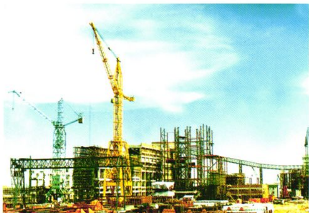
(1989年)沙角A电厂二期工程建设中
