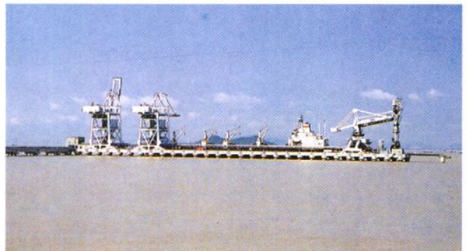
沙角 C 电厂煤码头
