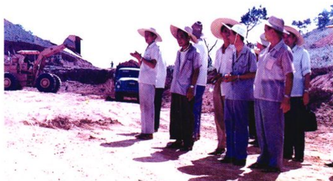
图为施工现场(1983年9月16日)
