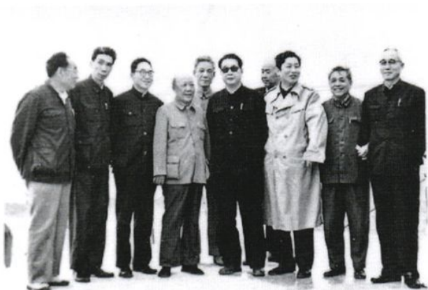
1984年4月7日李鹏副总理（右四）在省局领导师兆祥（左四）陪同下第一次视察沙角电厂工地
