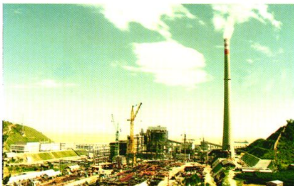
建设中的沙角A电厂工地
