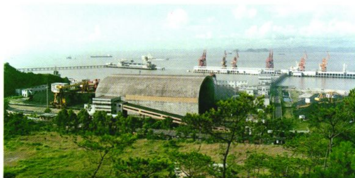
煤码头与煤场（1992年8月16日）
