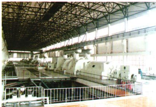
沙角A电厂二期工程2X30万 Kw上海产引进型机组
