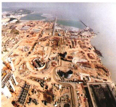
建设中的沙角C电厂工地
