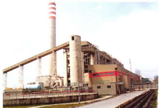
沙角C电厂厂房外景
