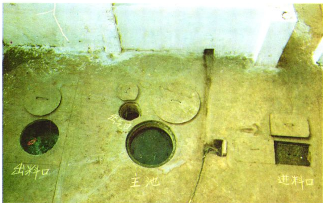
曲流布料沼气池外部结构
