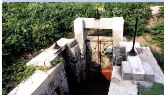
配套的闸洞沟渠
