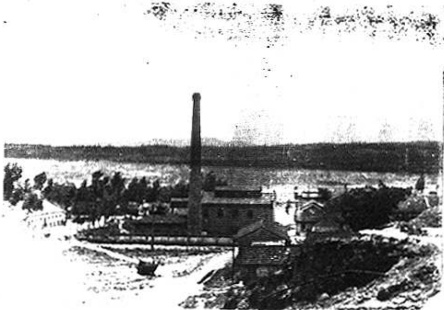
(3) 娘娘庙矿区锅炉房外景
