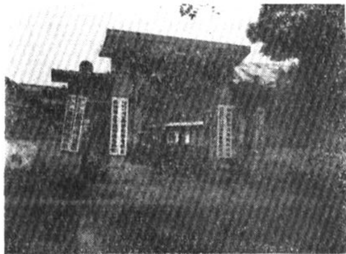
◇ 铁塔办事处派出所正门
