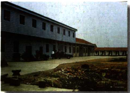
荣立金属材料公司利用坡地杂地建房
