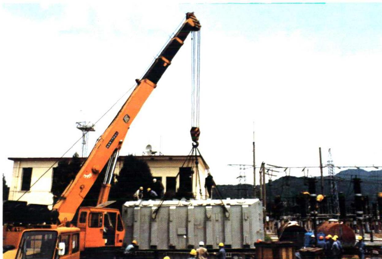
30 220千伏福州东郊变电站12万千伏安主变压器安装
