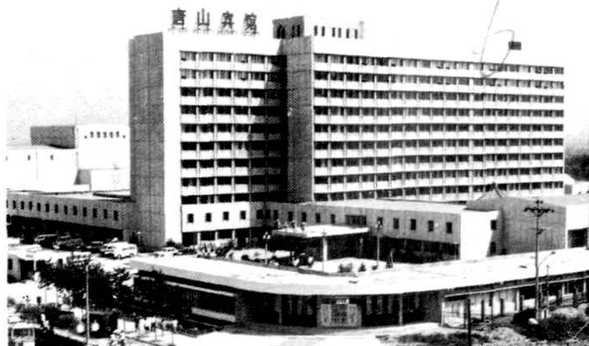
◇唐山宾馆大楼
