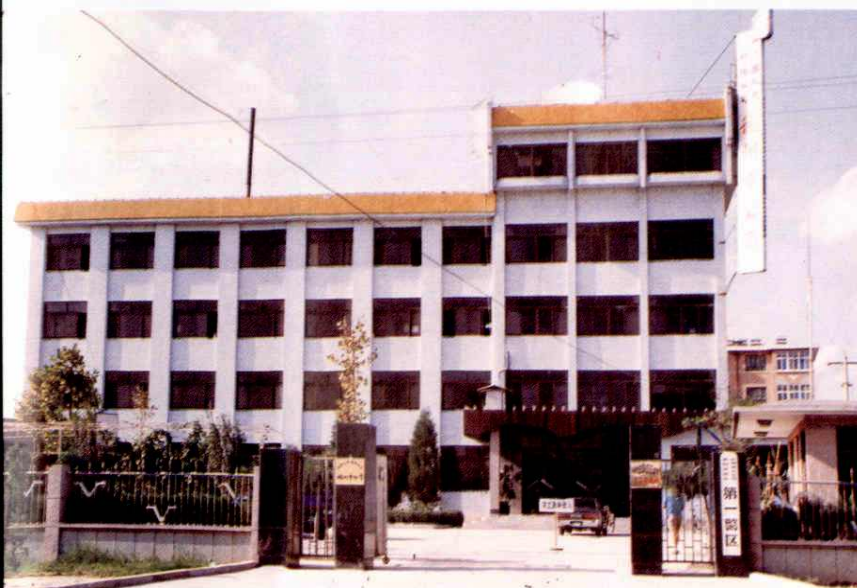
市保险公司办公楼
