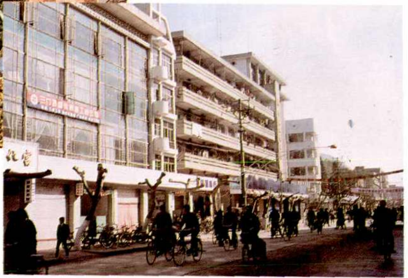
縣城建設新貌
