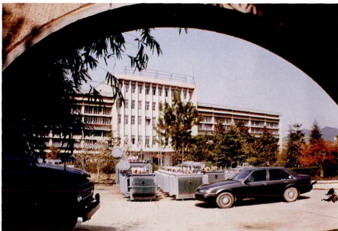
三門變壓器廠一角
