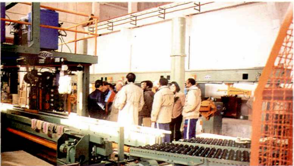
三門變壓器廠車間
