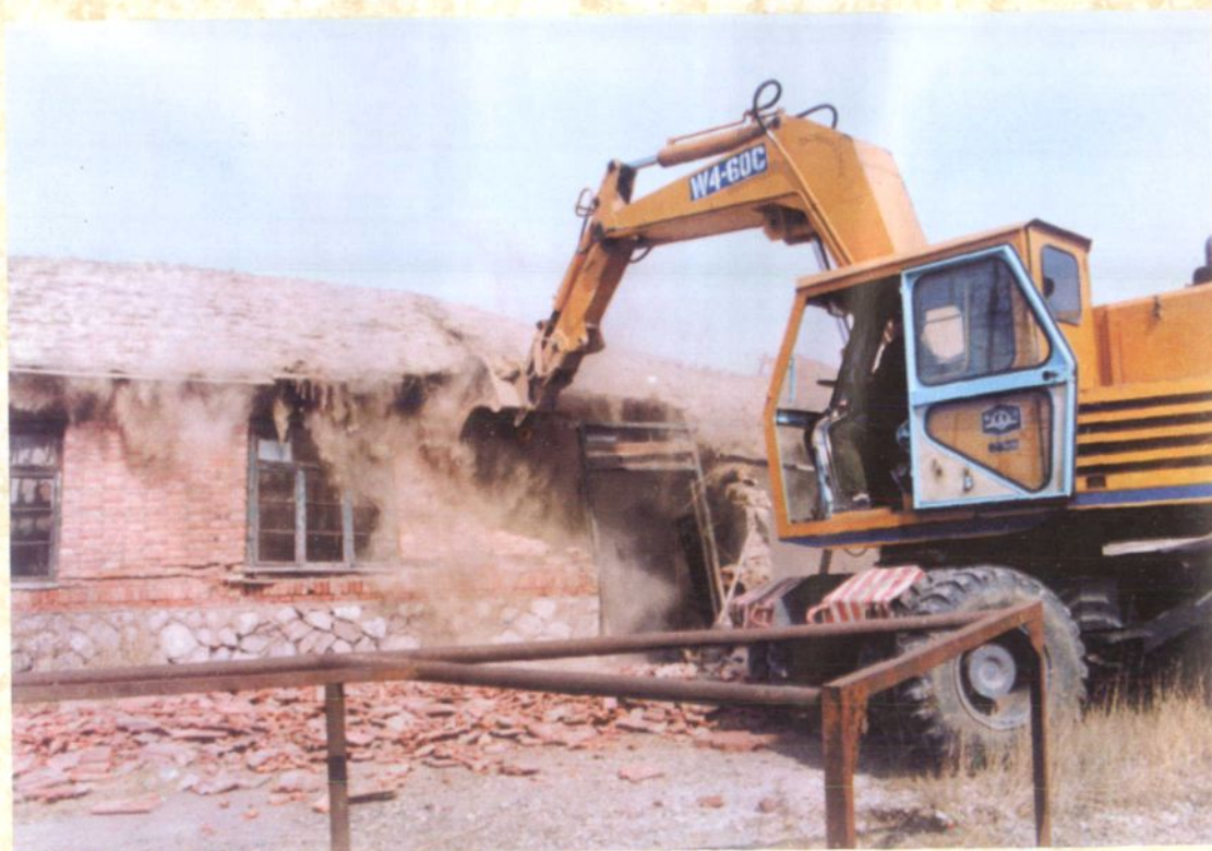
拆除违章建筑
