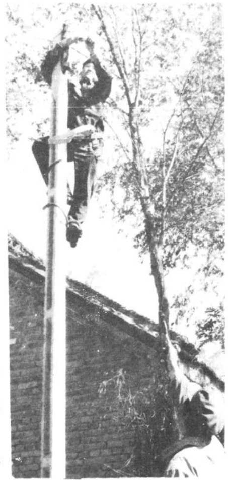
广播站机线员在架设广播专线
