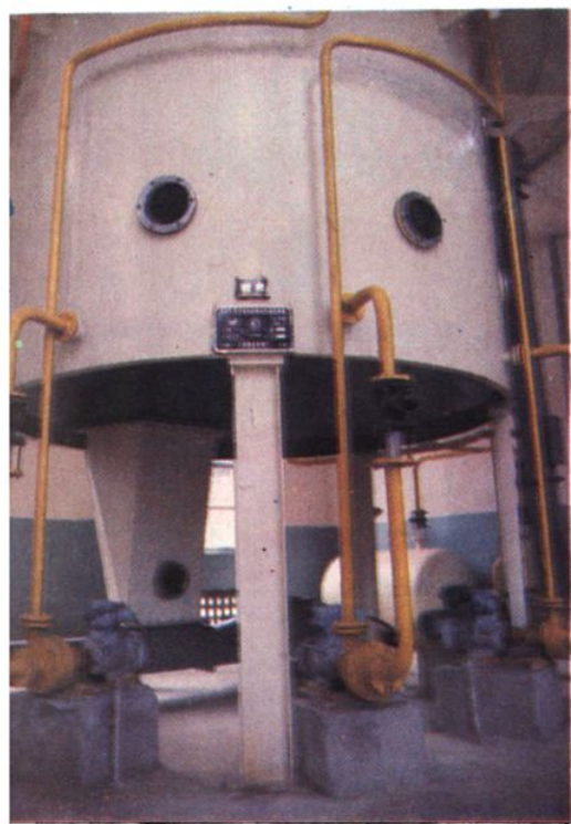
△浸出车间一角
