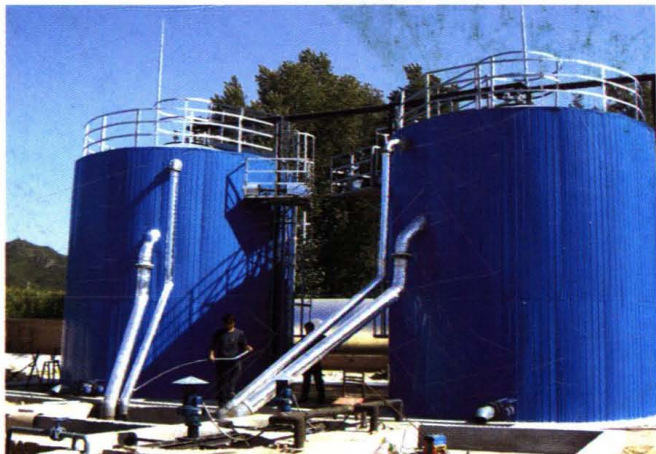
沼气配套太阳能热水安装工程
