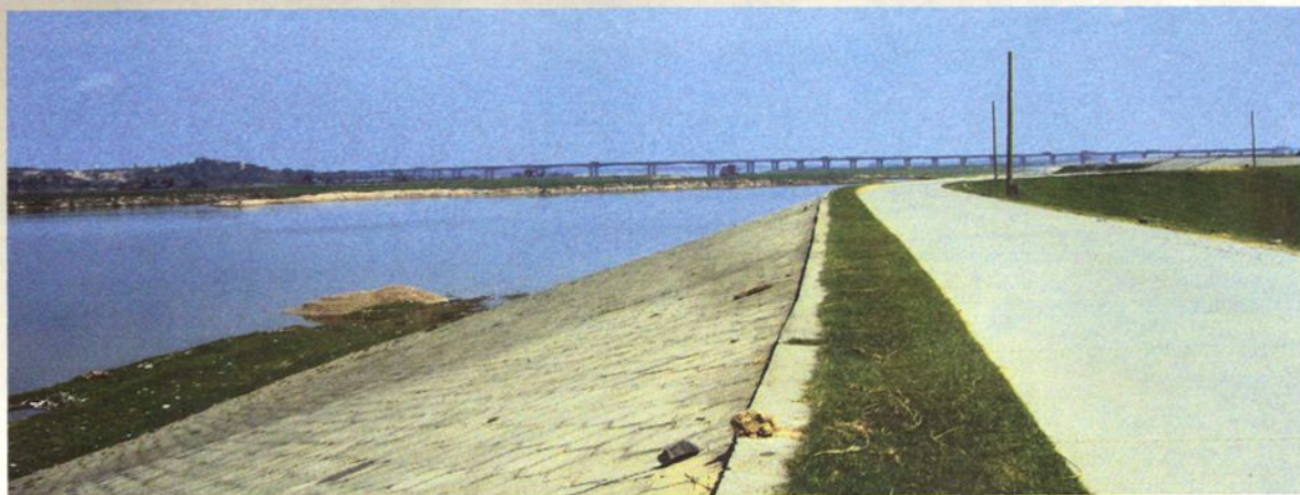
▲ 赣江航道及堤顶水泥公路(远处为龙王庙特大桥)
