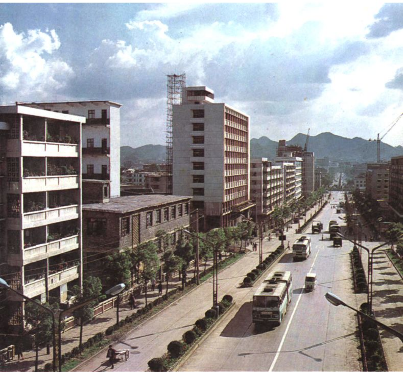
建设中的延安东路
