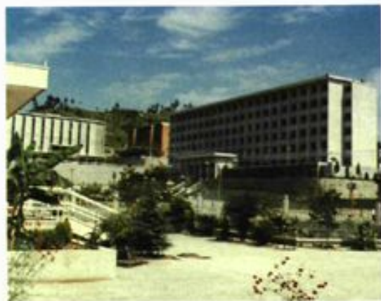
二汽总厂办公楼
