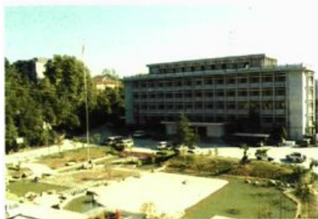
市政府办公楼
