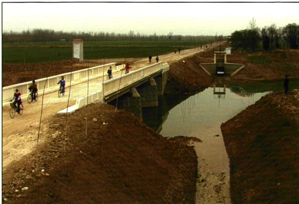
国家农业综合开发项目埇桥区苗庵乡治理片
