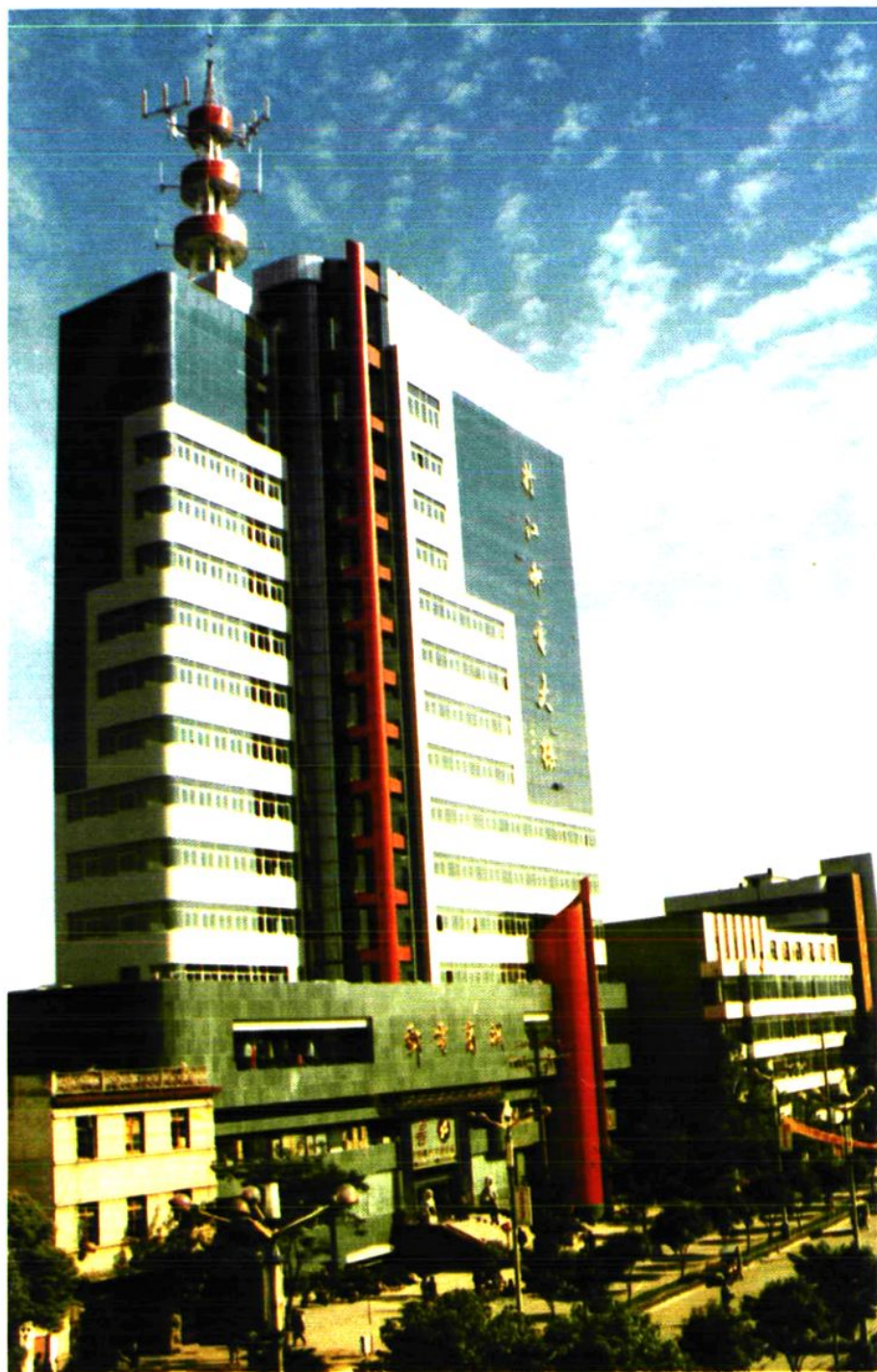
丹江邮电大楼
