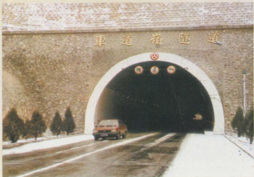
312 国道上的车道岭隧道
