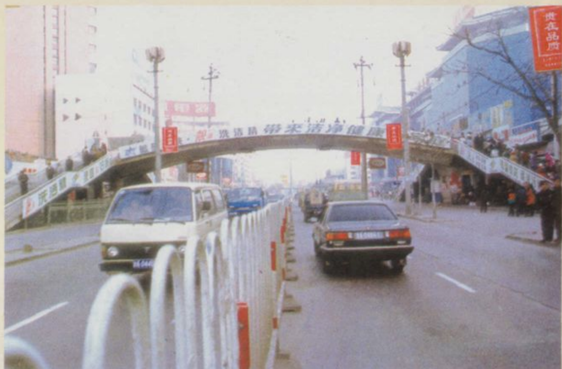
座落在民主西路的人行过街天桥,有效缓解了繁华街区人车混行的交通拥堵状况
