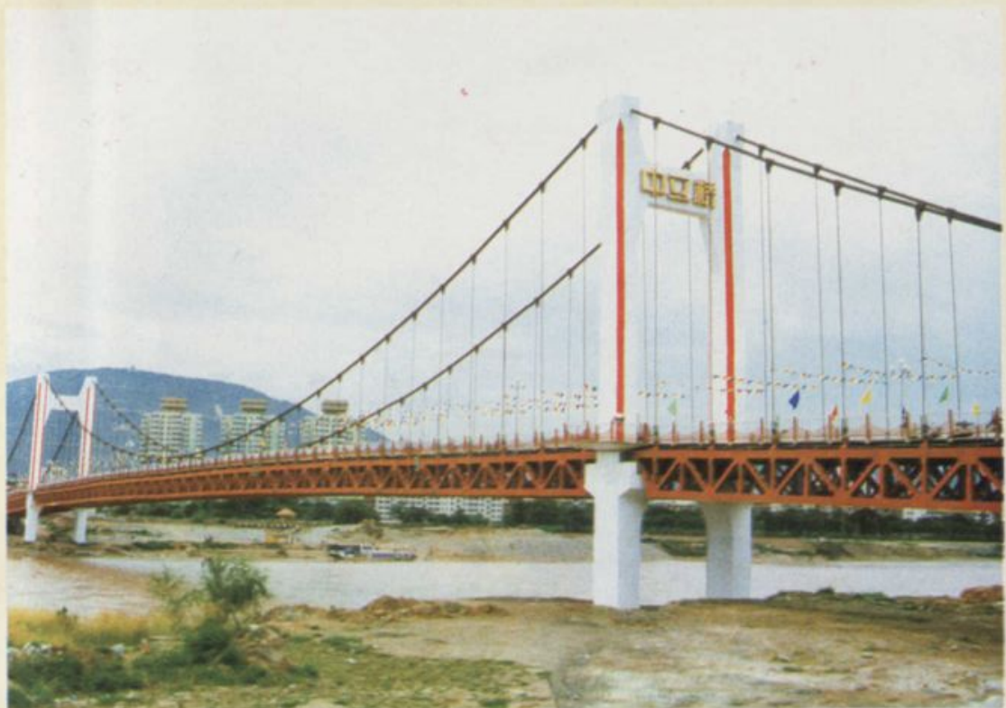
新建于滨河东路滩尖子至盐场堡的中立吊桥
