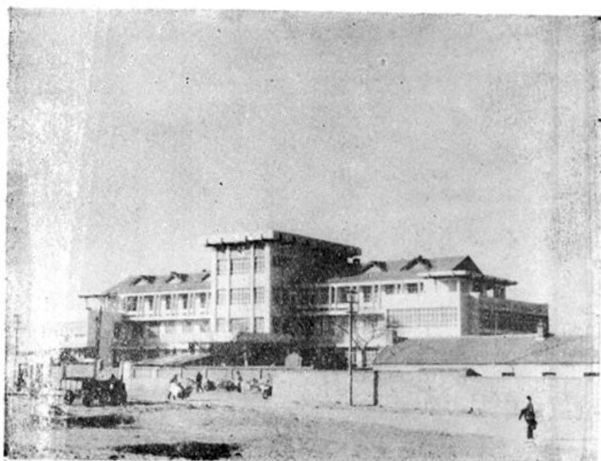
县第二人民医院新建门诊楼
