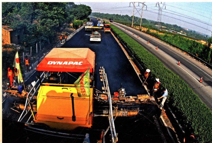
北新路桥公司陕西西一潼高速公路 工程施工现场
