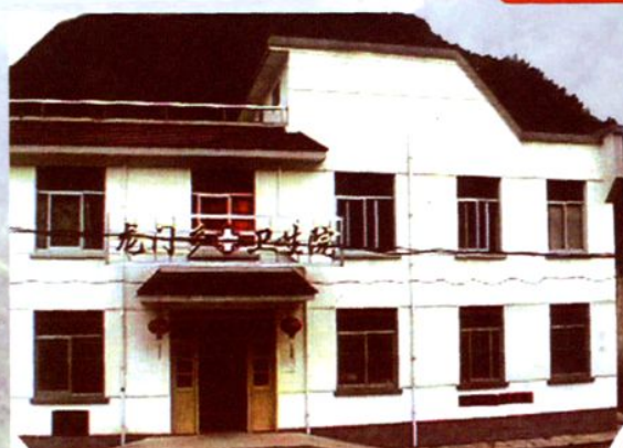
卫生院门诊楼
