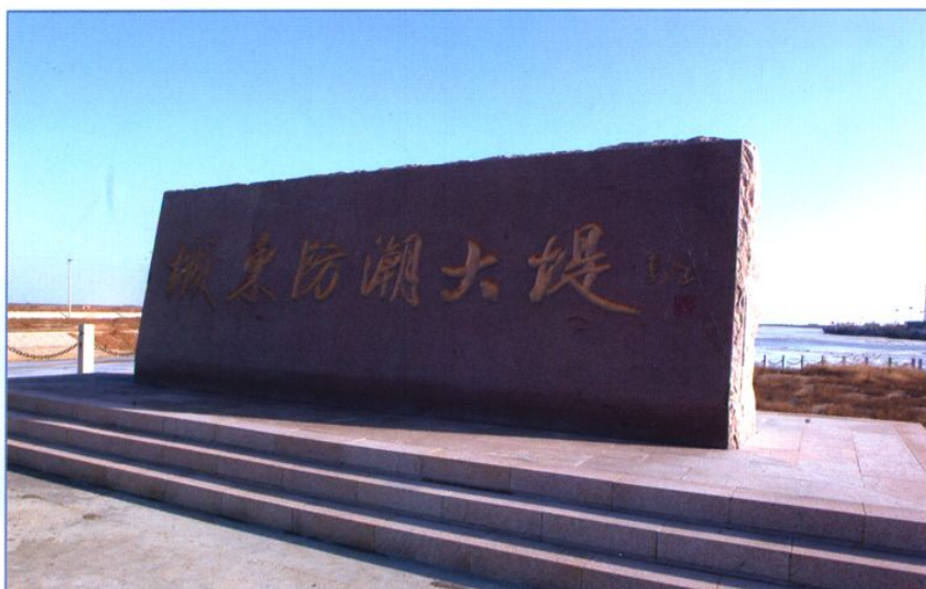
城东防潮大堤
