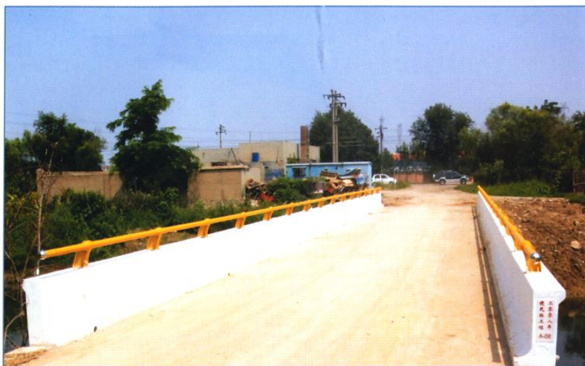
农村便民桥工程
