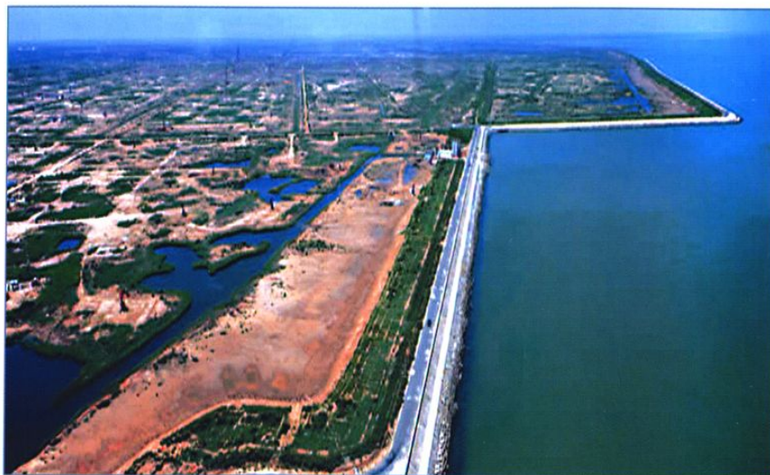
孤东防潮大堤
