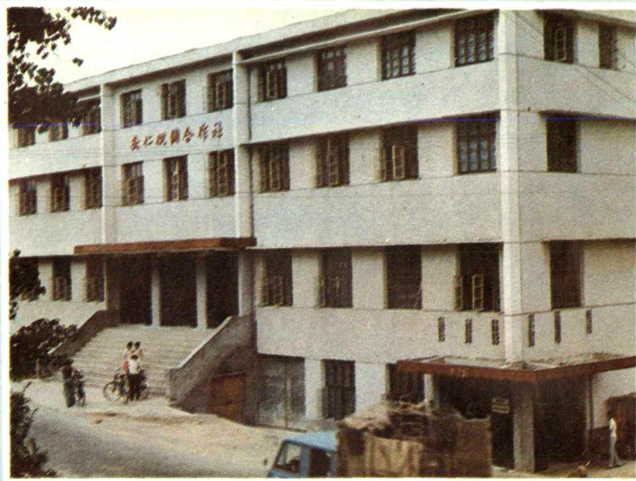
◀ 供销分社综合楼
