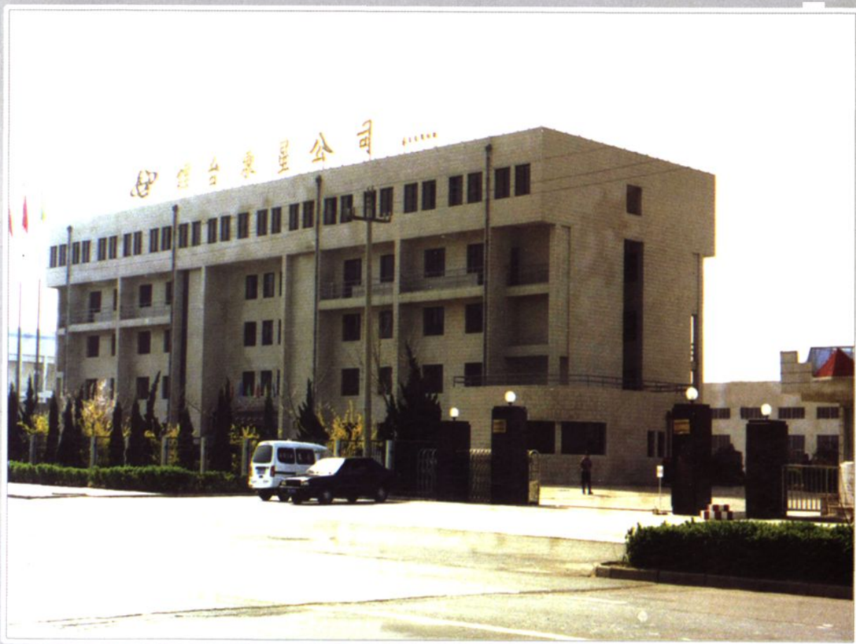
东星公司办公大楼
