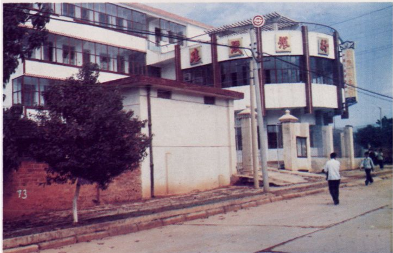
建设银行行址
