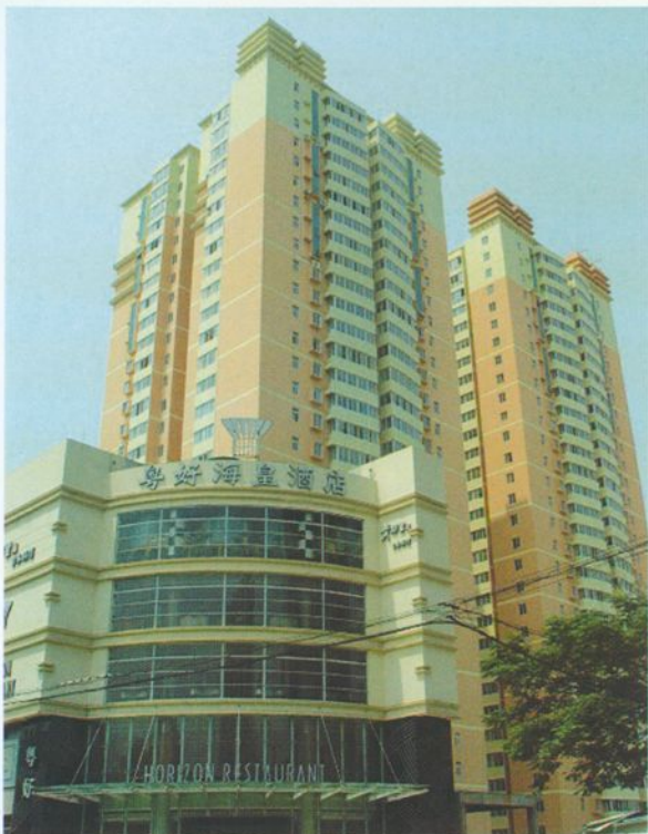
北沙坡村一期改造项目村民安置楼
