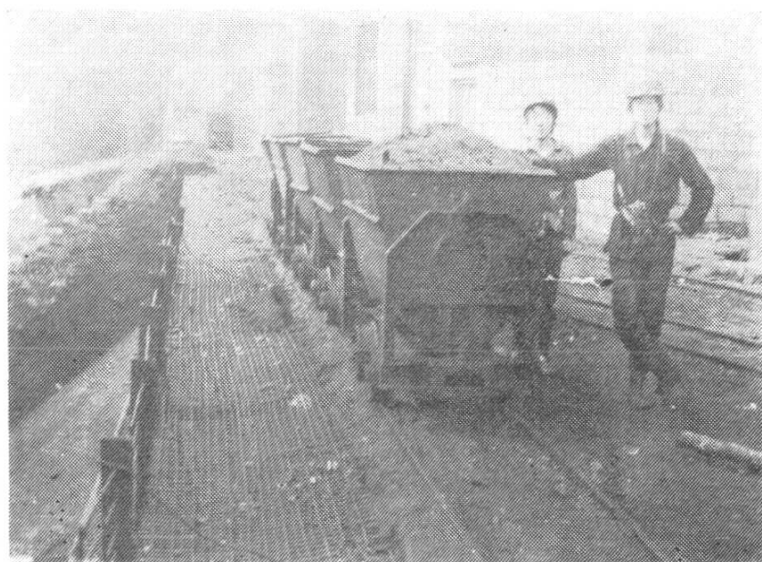
工农煤矿工业广场
