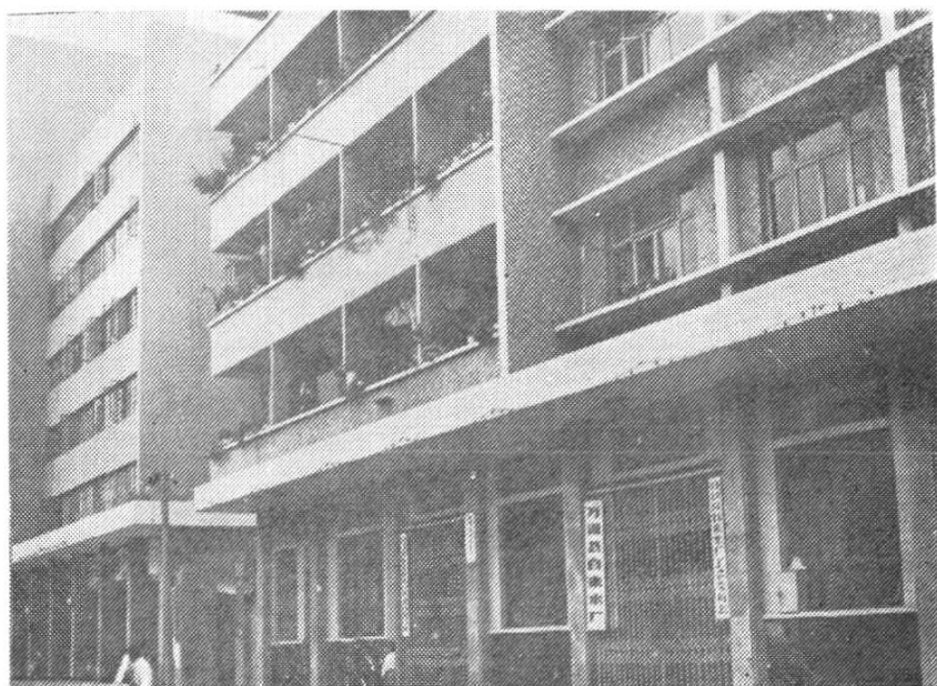
自来水厂综合楼
