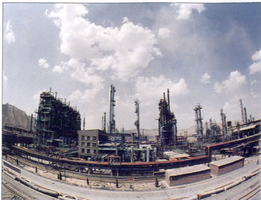
甘肃省建行支持建设的兰化公司年产8万吨乙烯毫秒炉装置
