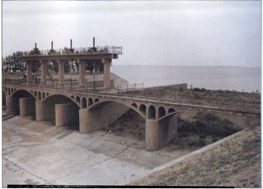
甘肃省建行支持建设的民勤红崖山水库
