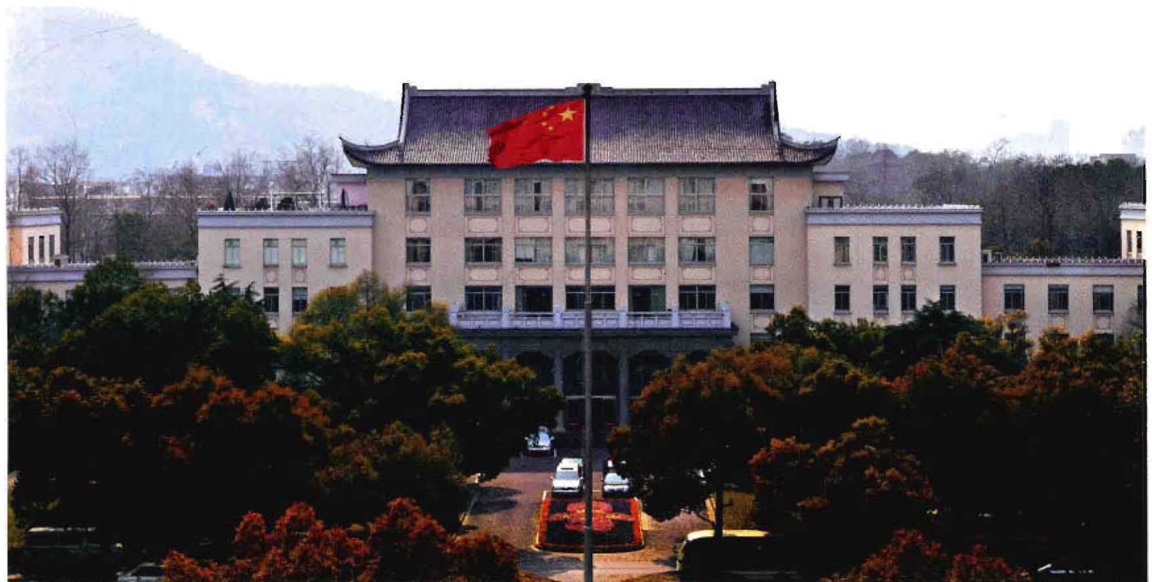
▲ 浙江省人民政府办公楼(省行政中心1号楼)
