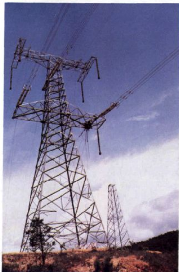
参建的500kV云南大朝山—昆明南回输电线路工程（2003，部优）
