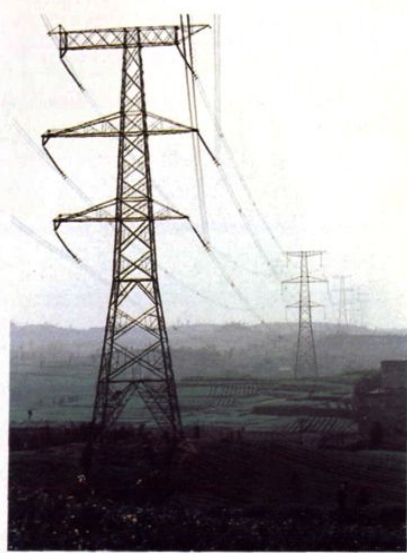
参建的中国第一条500kV同塔双回四川自贡—蓉城输电线路（1997）
