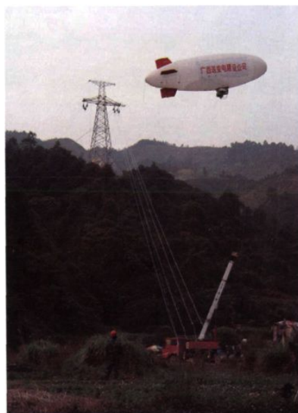
遥控氦气飞艇展放引绳跨越施工
