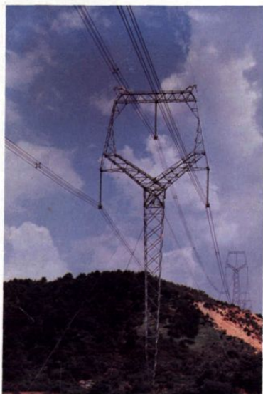
承建的500kV岩滩—平果输电线路工程（1995，省优）
