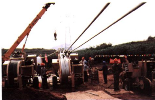
意大利500kV张力放线设备架线施工
