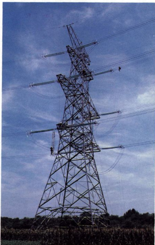
参建的500kV山西阳城—淮阳输电线路工程（1998）
