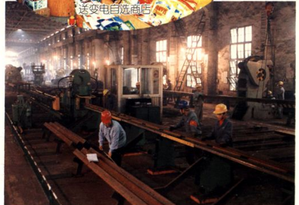
铁塔厂自动化铁塔生产线
