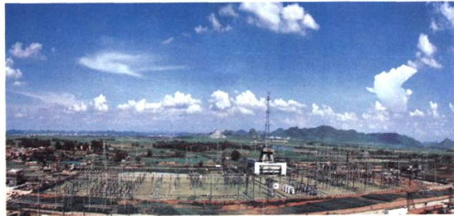
承建的第一座500kV来宾变电站工程（1989）
