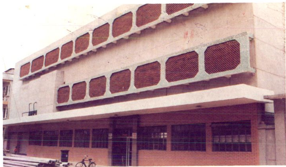
畚江电信大楼
