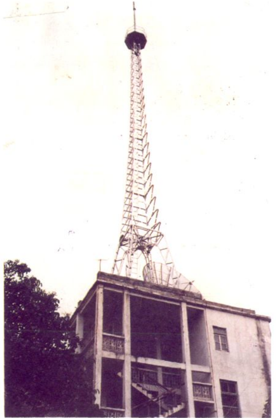
畲江电视卫星地面接收站
