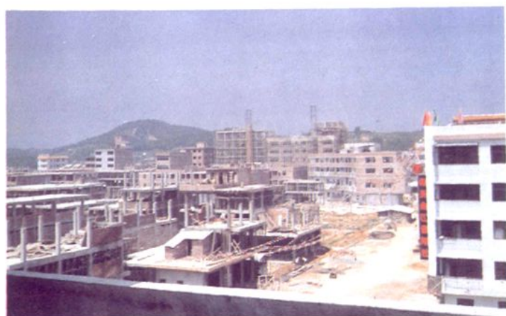
正在建设中的新圩镇 第二期工程
