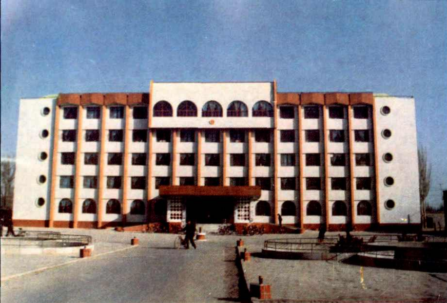
县人民政府办公楼
