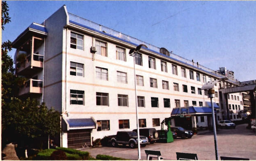
2008 年建成州气象局业务 办公楼
