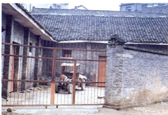
▲高镇转运站化肥仓库
